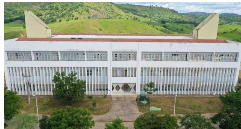
Prédio do Icet
