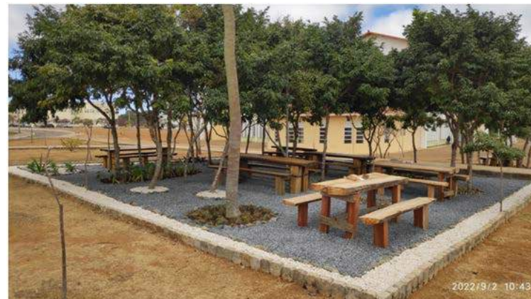
Reforma e ampliação do espaço verde da Reitoria
