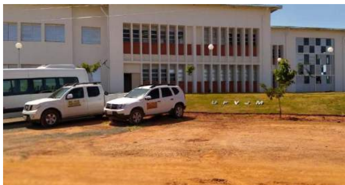
Área interna e estrutura do setor administrativo, biblioteca e gabinetes de docentes do Campus Janaúba
